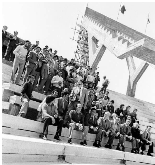
En otro partido, con la nueva grada casi terminada
