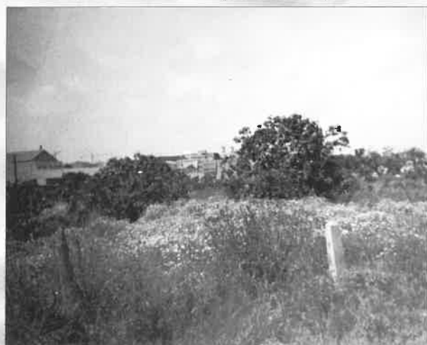
Detrás vemos las torres de la iglesia de Los Ángeles y la chimenea de la Cerámica.
